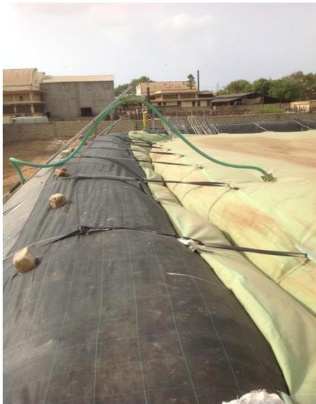
Réseau gazoduc+soupape sécurité
