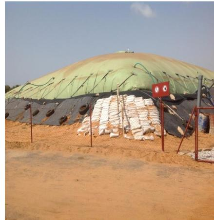
Digesteur rempli de biogaz
