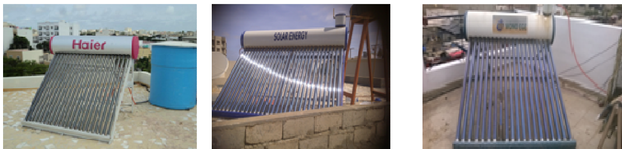
Figure 9: Photos de chauffe eau solaires à tubes sous vide dans des maisons
